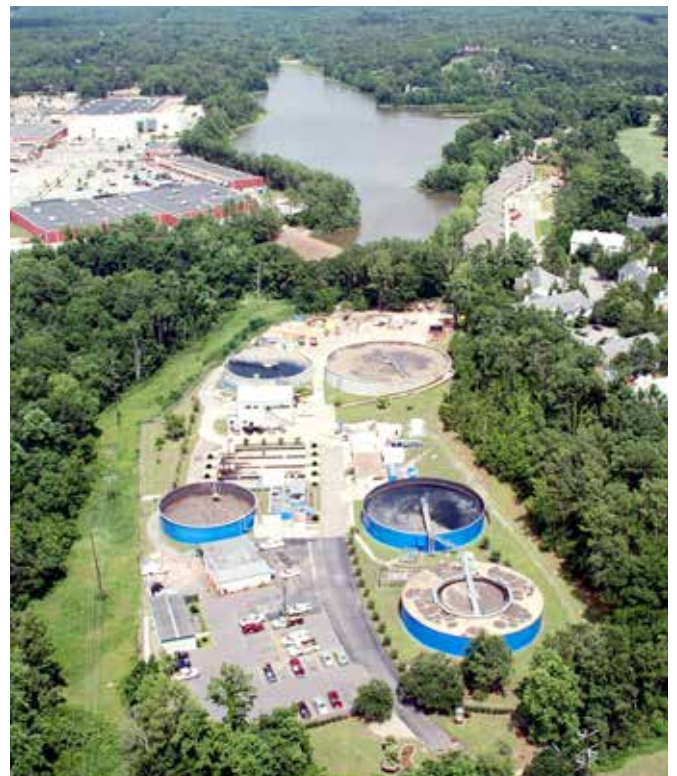
Figura 1. L'impianto di depurazione delle acque di scarico Daphne Utilities aveva uno spazio limitato per nuove apparecchiature
